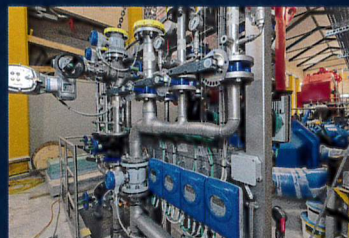
Technische Einrichtungen Kraftwerk Tannuwald
