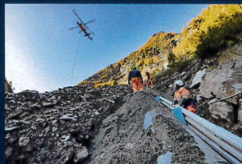
Bau Druckleitung
