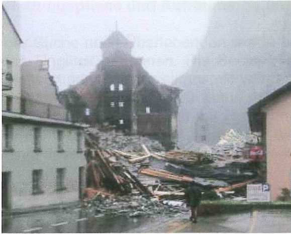
Abb.12: Der zerstörte Stockalperturm
